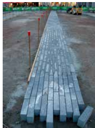
Stenläggning mellan grönstrukturer i Bryssels gamla stad.
